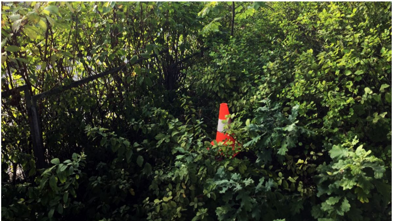
_ Dieser Hydrant ist vollkommen überwuchert | Foto: FF Lugau
