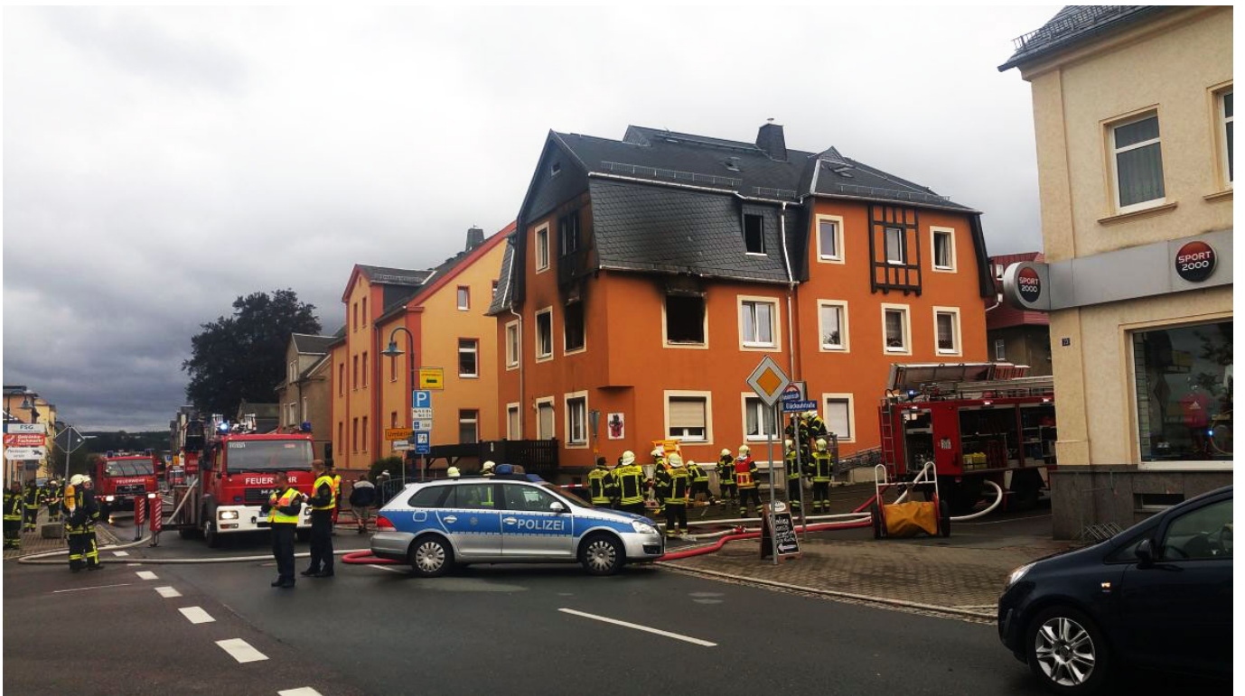
_ Zustand des Hauses nach den Löscharbeiten: Die Wohnung ist nicht bewohnbar
