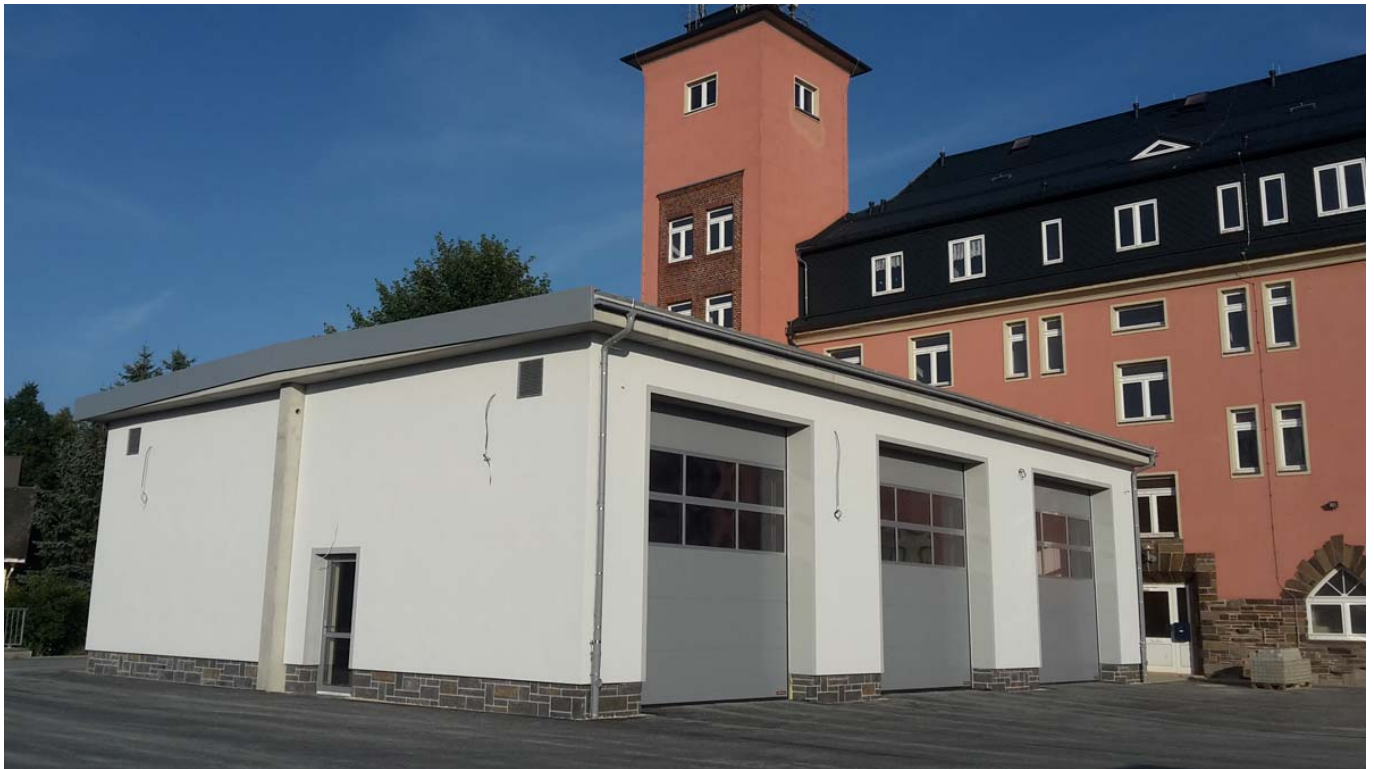
– Außenansicht der neuen Fahrzeughalle - noch ohne Beleuchtung | Foto: FF Lugau/Schimmel
