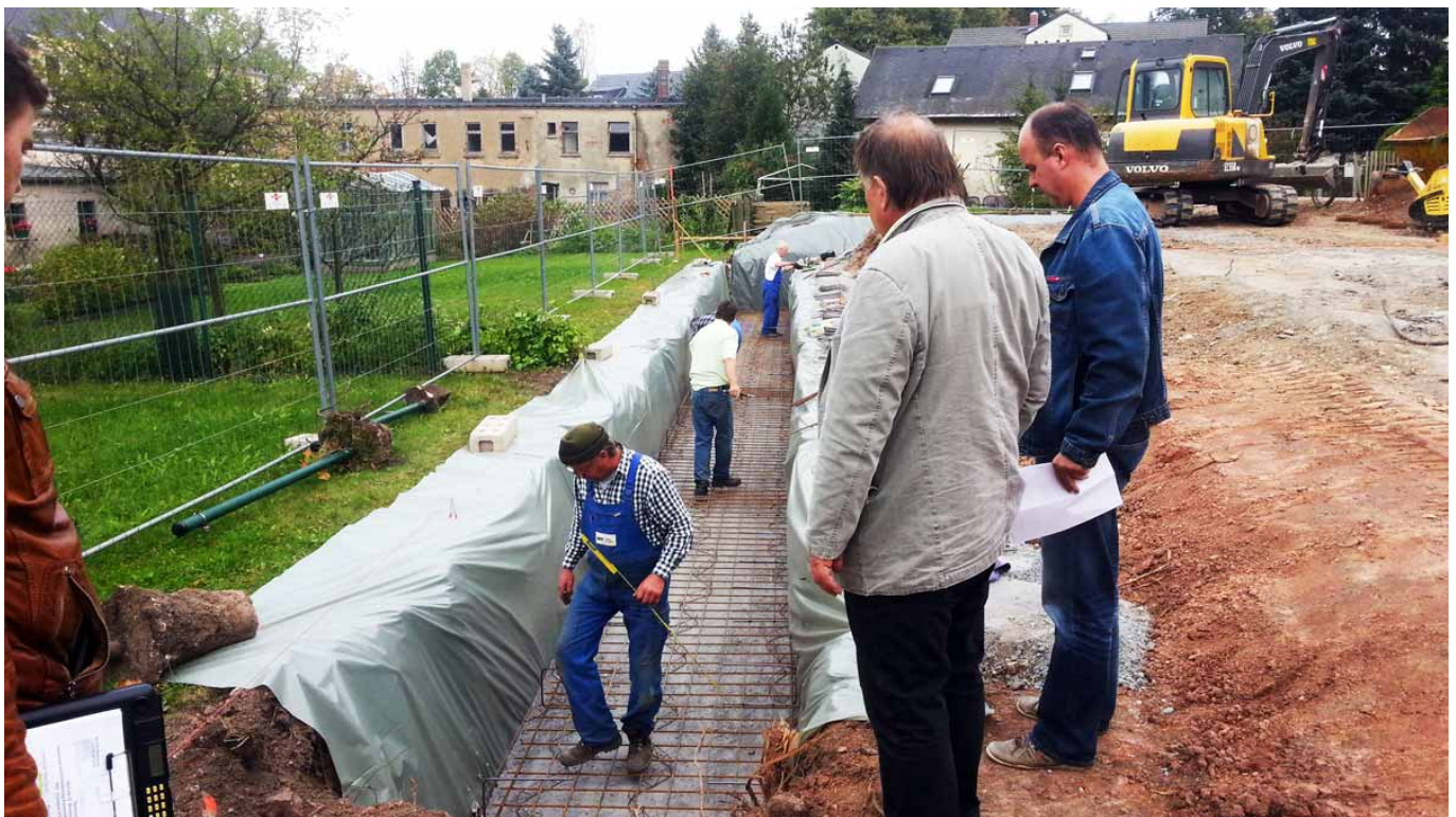
_ Bauarbeiten im Oktober: Das Fundament der Mauer wird gebaut
