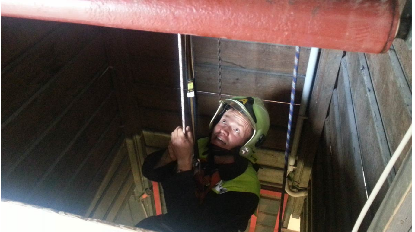
Sportlich: Gerätewart Sven Colditz beim Verlegen von Kabel im Schlauchturm - Bildrechte: FF Lugau
