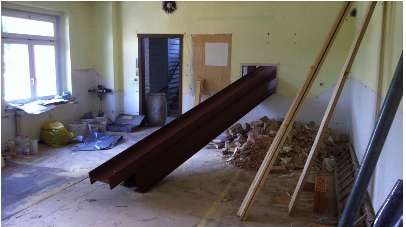
Der Fußboden wird gelegt - Bildrechte: FF Lugau
